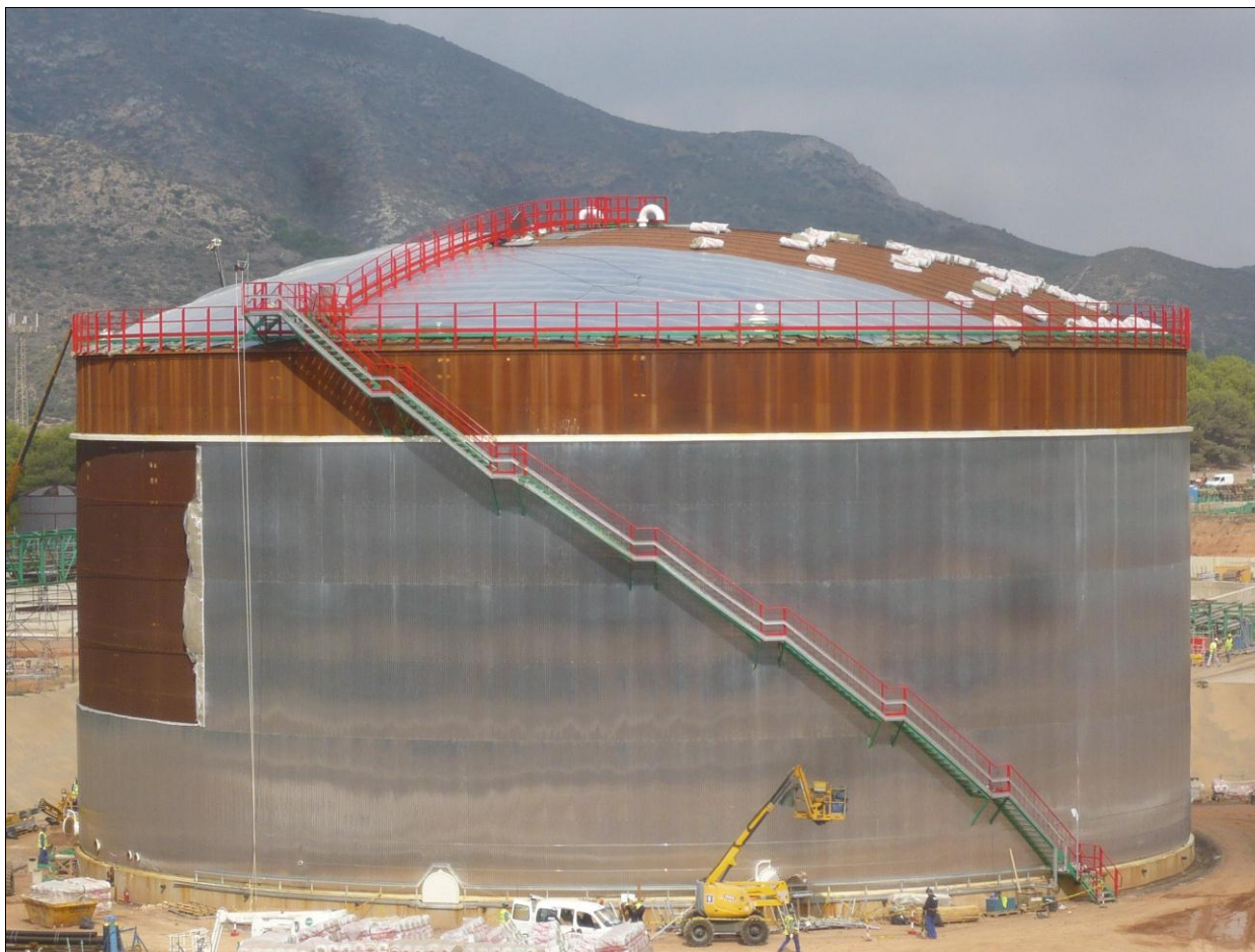
Tanque almacenamiento Residuo de Vacío (Ø46 x 20 mtrs. -33.238 m3) para Repsol (C.I. Cartagena-Proyecto C10)
