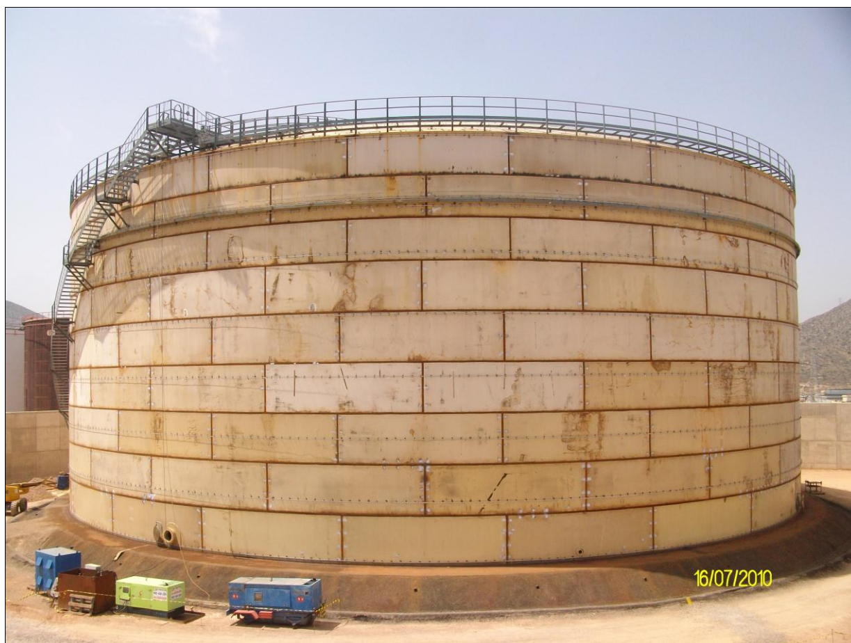
Tanque almacenamiento Residuo Atmosférico ( \varnothing 53 \times 22 mtrs -48.536 m3) para Repsol (C.I. Cartagena-Proyecto C10)
