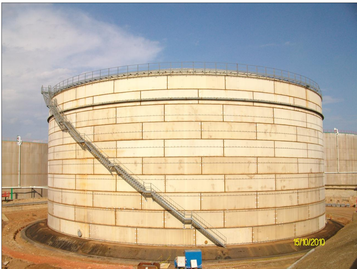
Tanque almacenamiento Residuo Atmosférico (Ø53 x 20 mtrs. -44.123 m3) para Repsol (C.I. Cartagena-Proyecto C10)
