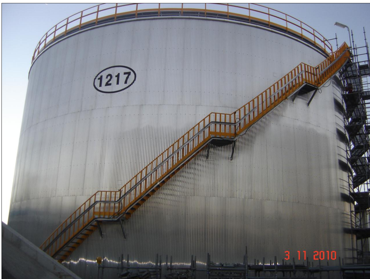
Tanque almacenamiento Gas Oil ( \varnothing 24 \times H12 mtrs.) para Cepsa (Refinería Algeiras)
