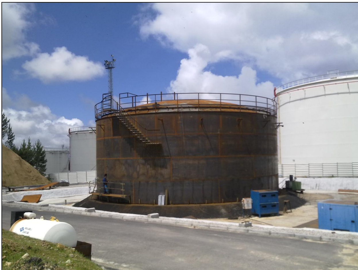
Tanques (3) almacenamiento Gasolina ( \varnothing 20 \times H16 mtrs.) para C.L.H. (I.A. Vigo)
