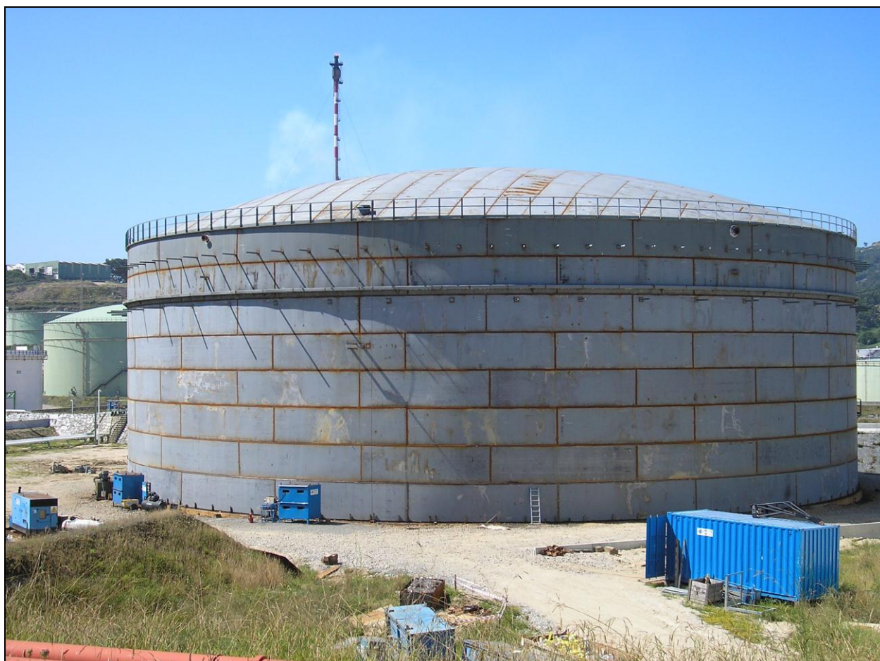
Tanques (2) de almacenamiento de Gas oil ( \varnothing 50 \times 22 mtrs – 43.196 m3) para Repsol (Refinería A Coruña)
